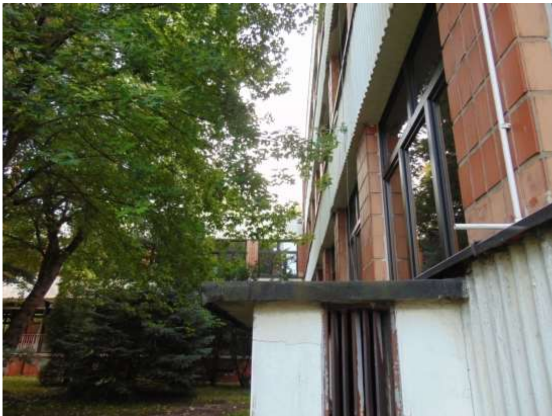
zdjęcie nr 25 - Elewacja budynku głównego "C"
