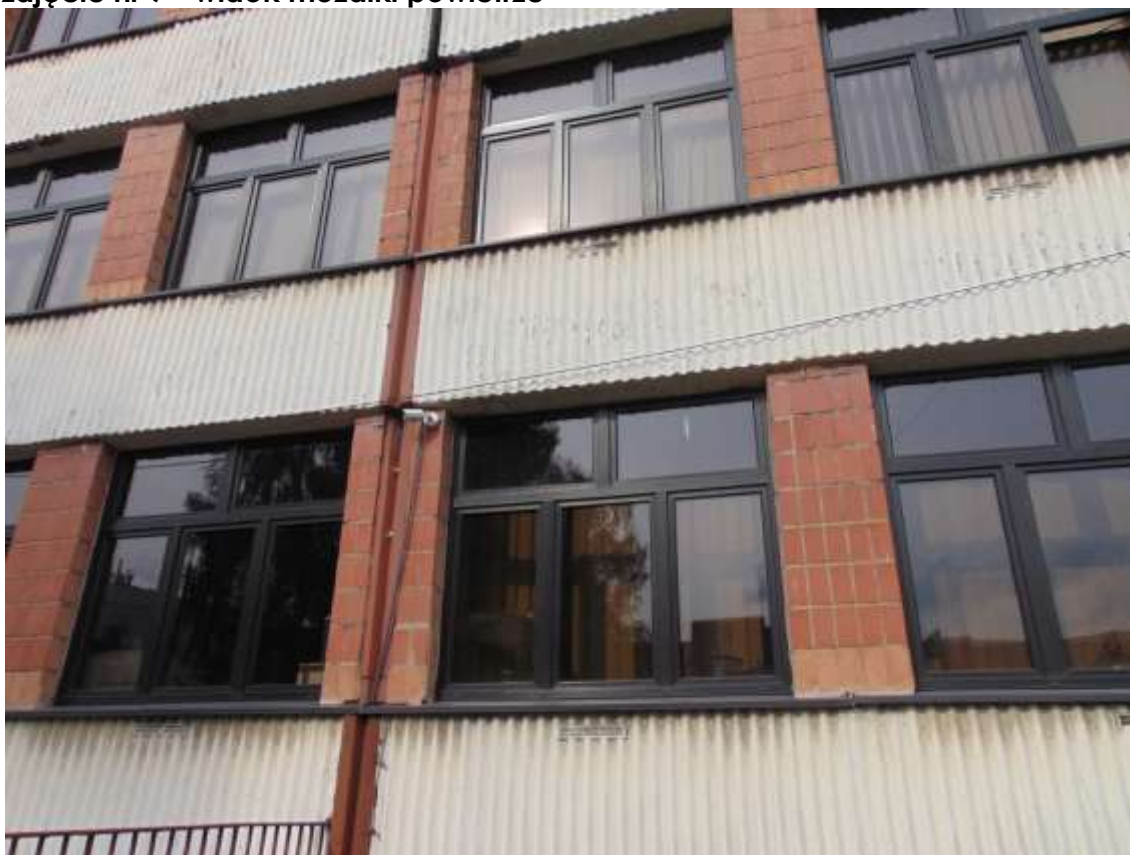
zdjęcie nr 10 - widok elewacji nr 6
