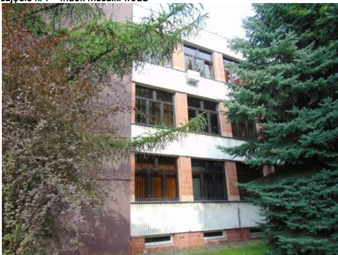
zdjęcie nr 8 - widok elewacji nr 7
