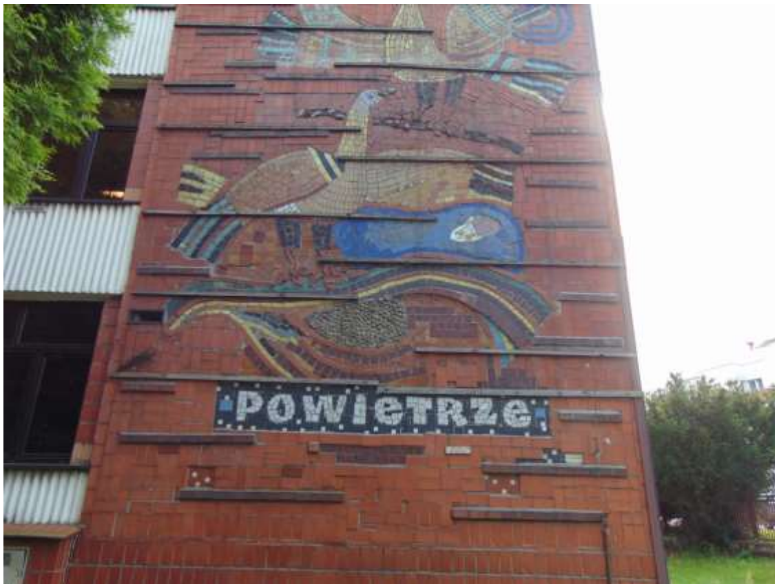
zdjęcie nr 9 - widok mozaiki powietrze
