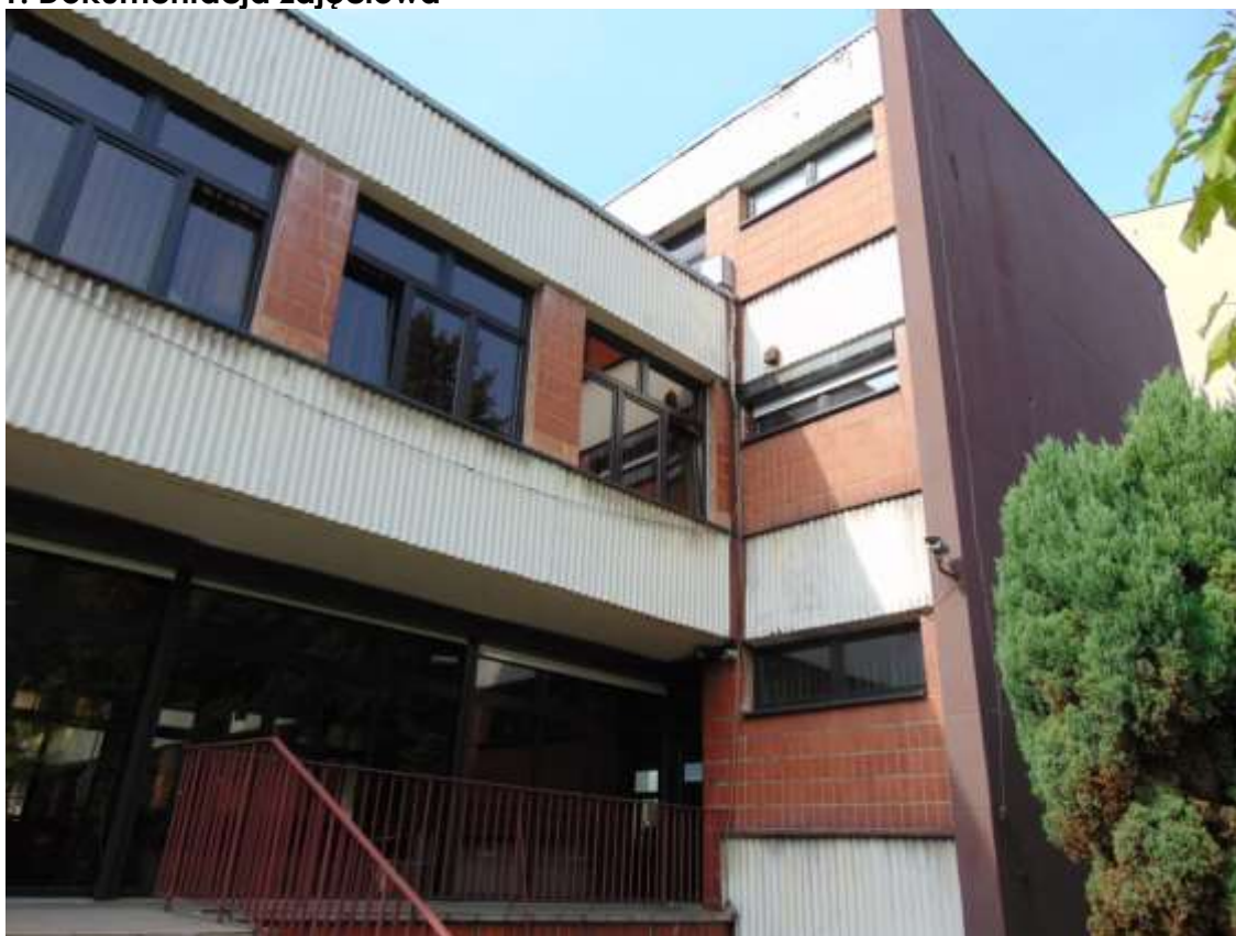
zdjęcie nr 1 - widok elewacji nr 5
