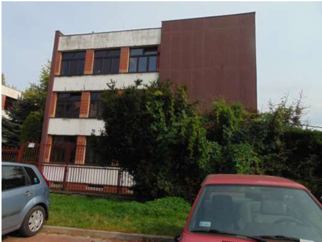
zdjęcie nr 14 - elewacja nr 5
