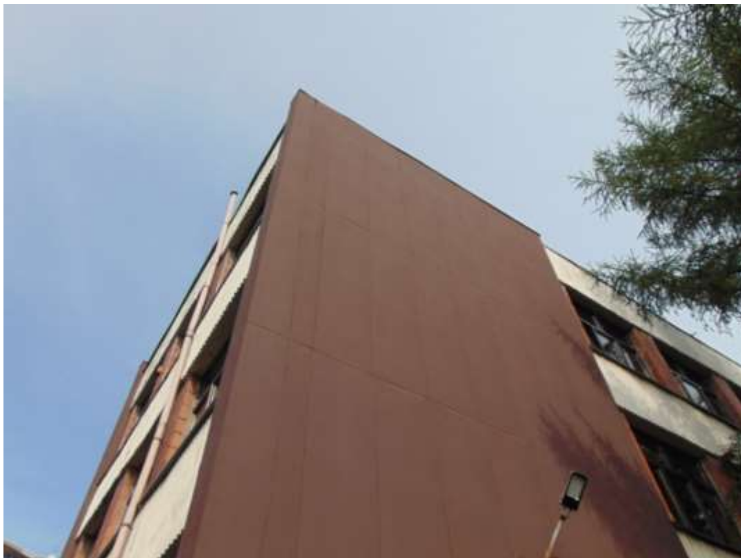
zdjęcie nr 20 - elewacja nr 5 - płyty azbestowe
