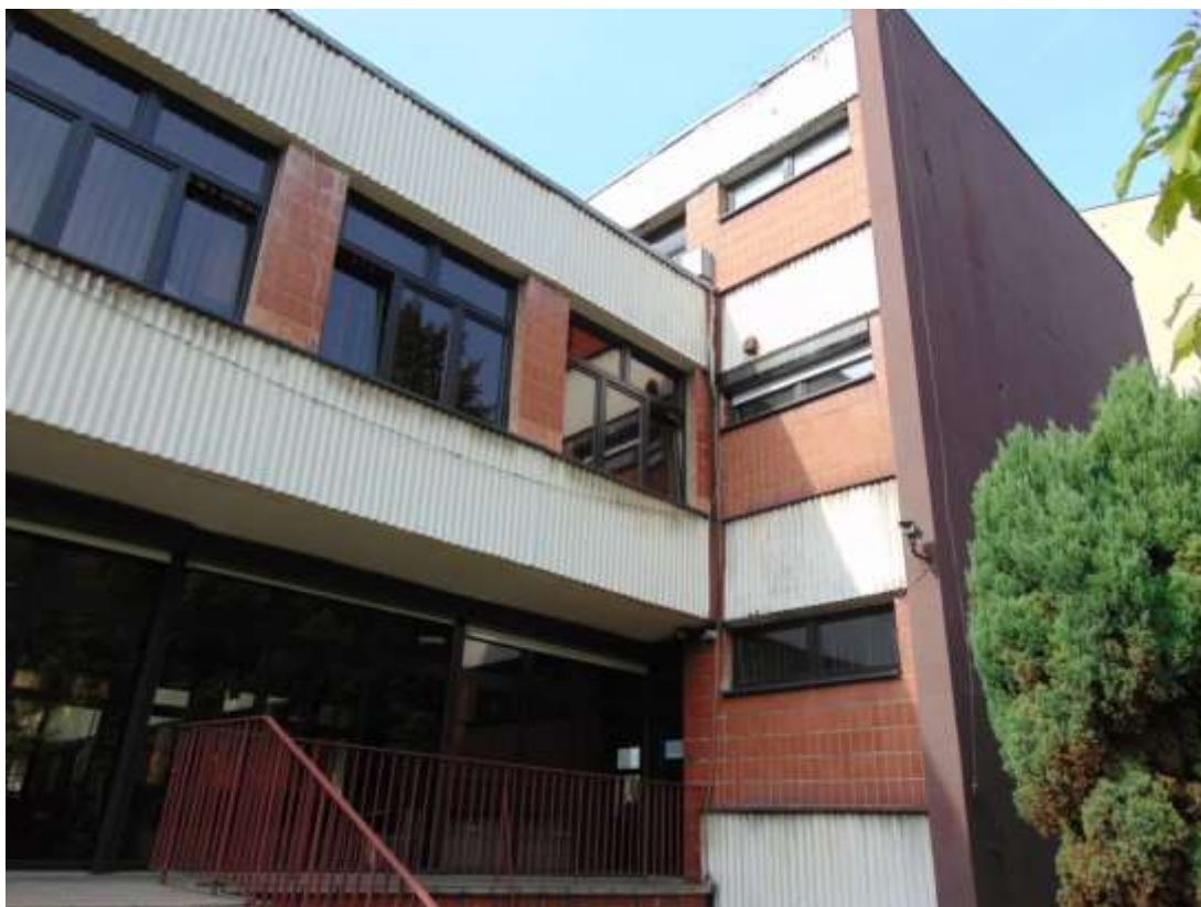
zdjęcie nr 27 - elewacja nr 2
