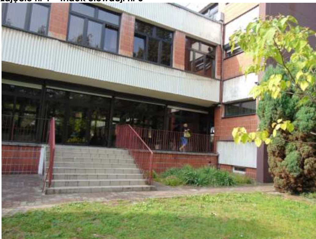
zdjęcie nr 2 - widok elewacji nr 5
