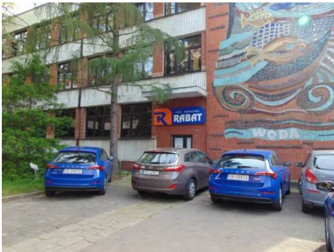
zdjęcie nr 23 - Elewacja budynku głównego "B"
