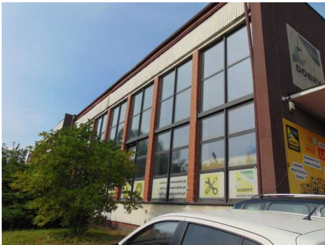
zdjęcie nr 11 - widok elewacji nr 4
