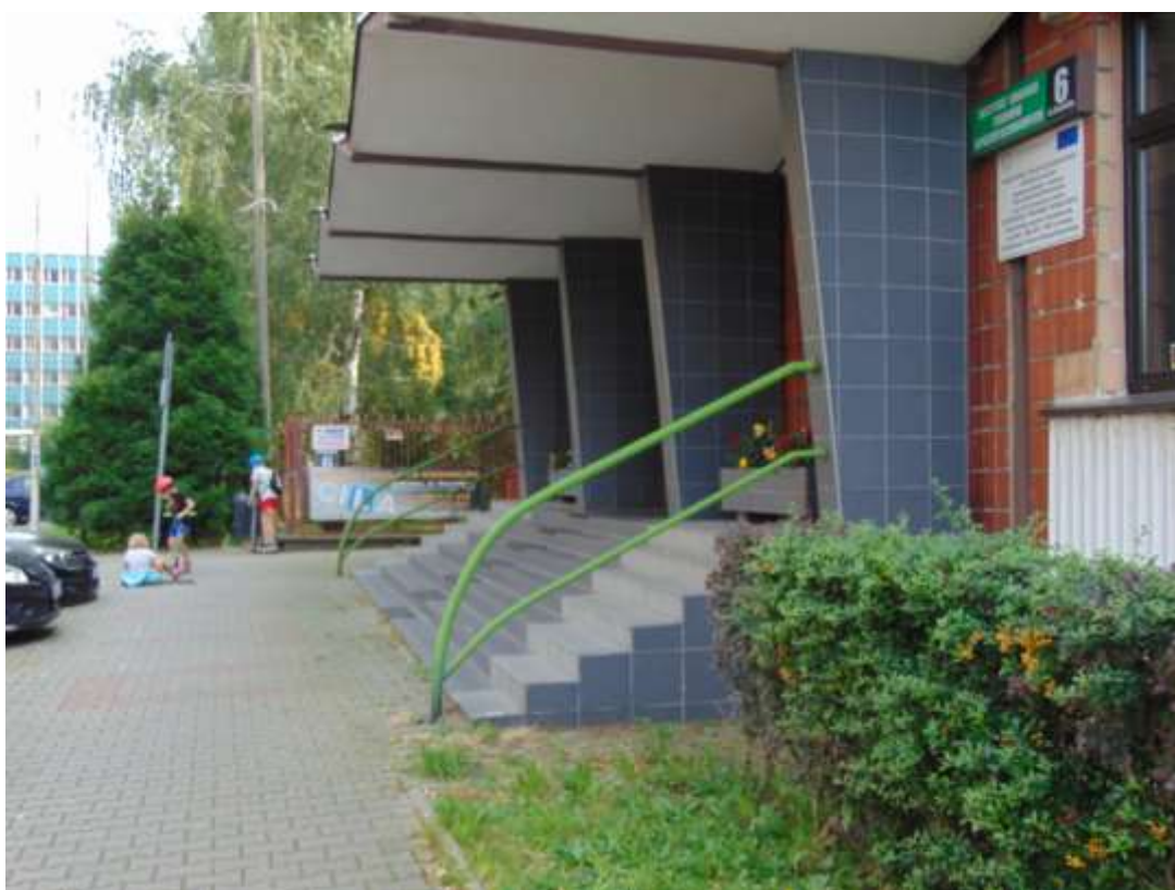
zdjęcie nr 6 - front budynku, elewacja nr 1
