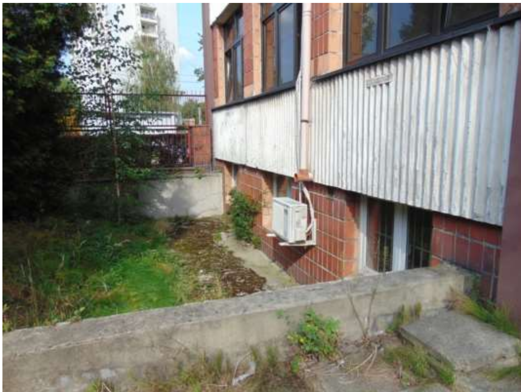
zdjęcie nr 18 - widok elewacji
