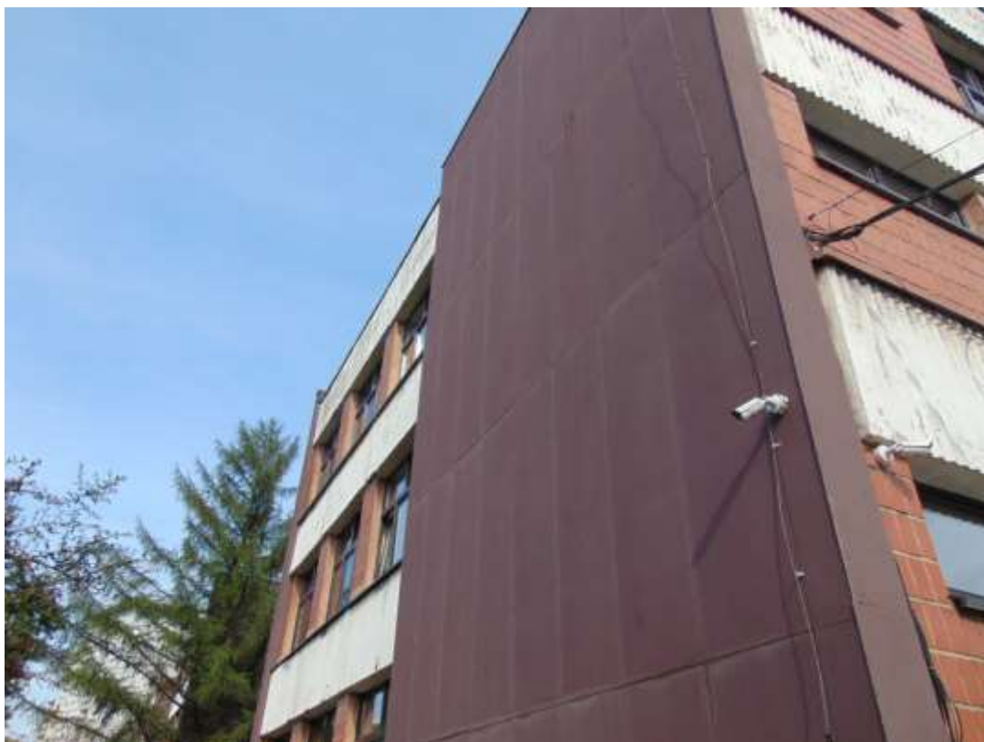
zdjęcie nr 5 - widok elewacji nr 5
