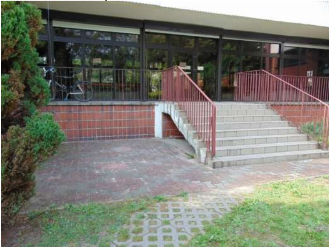
zdjęcie nr 13 - elewacja nr 2
