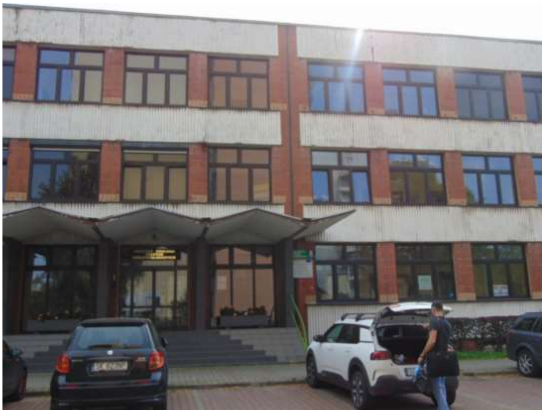
zdjęcie nr 21 - Elewacja frontowa budynku głównego "A"
