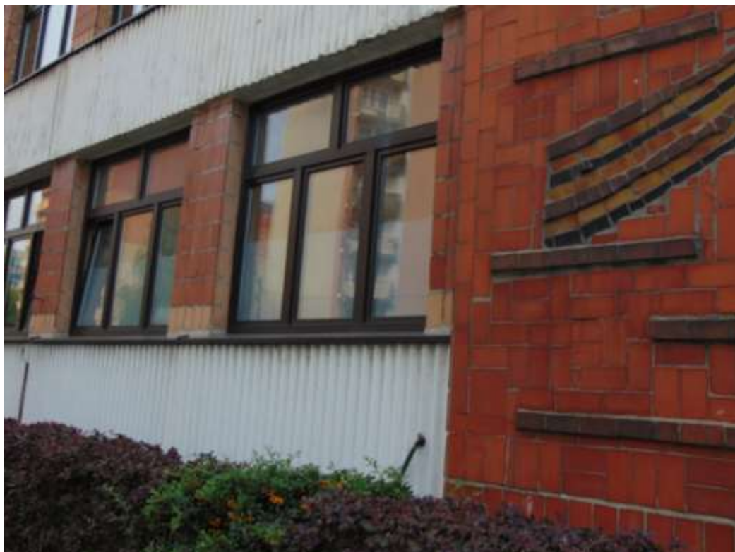
zdjęcie nr 15 - elewacja nr 1
