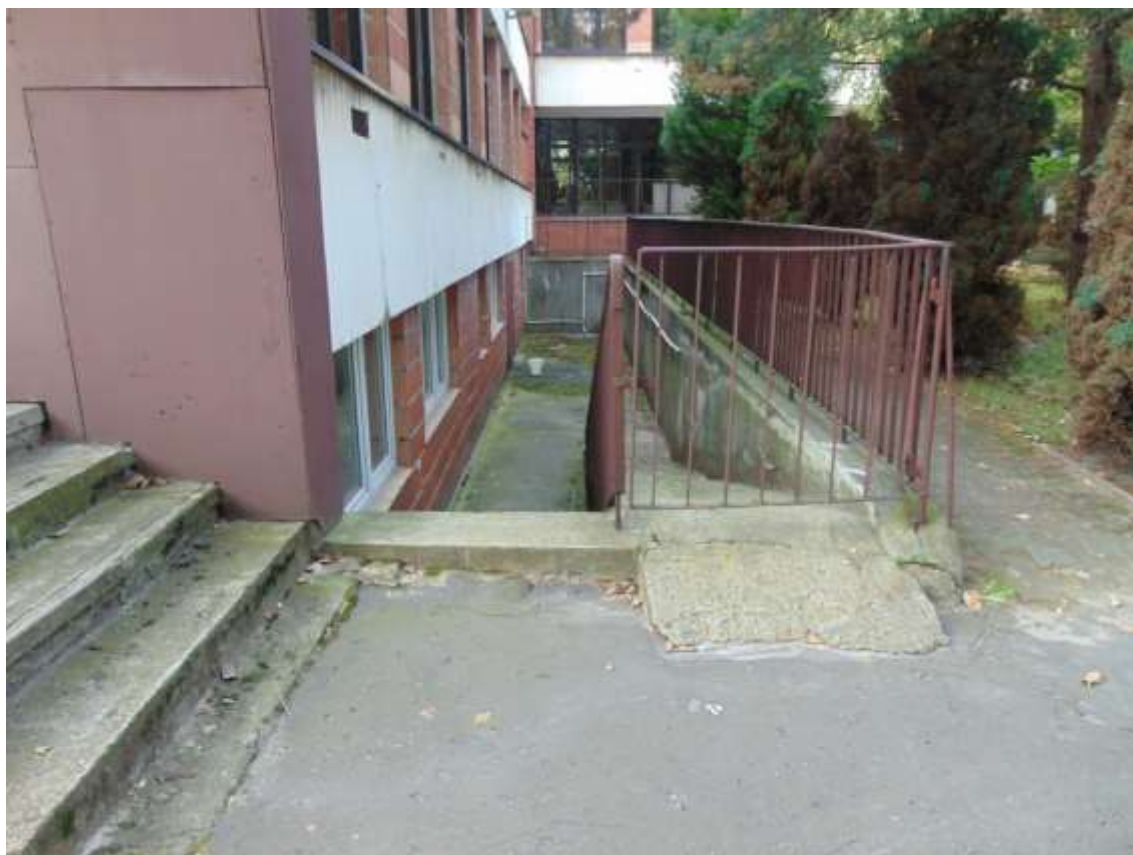
zdjęcie nr 12 - widok elewacji nr 3
