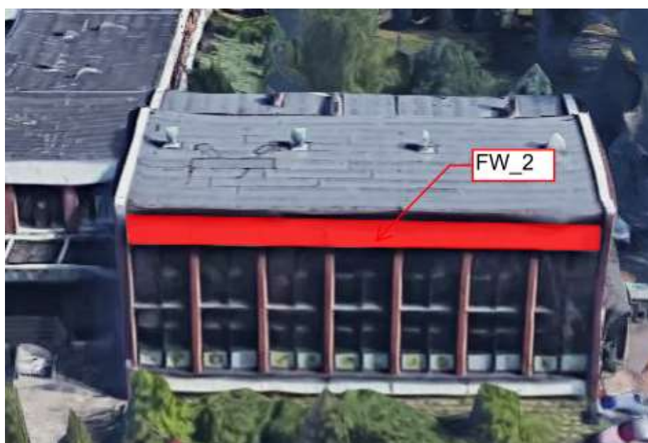
Elewacja południowa – budynek hali
