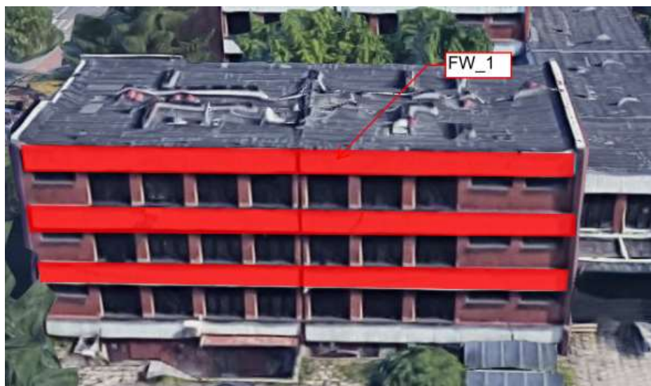
Elewacja południowa – budynek biurowy
