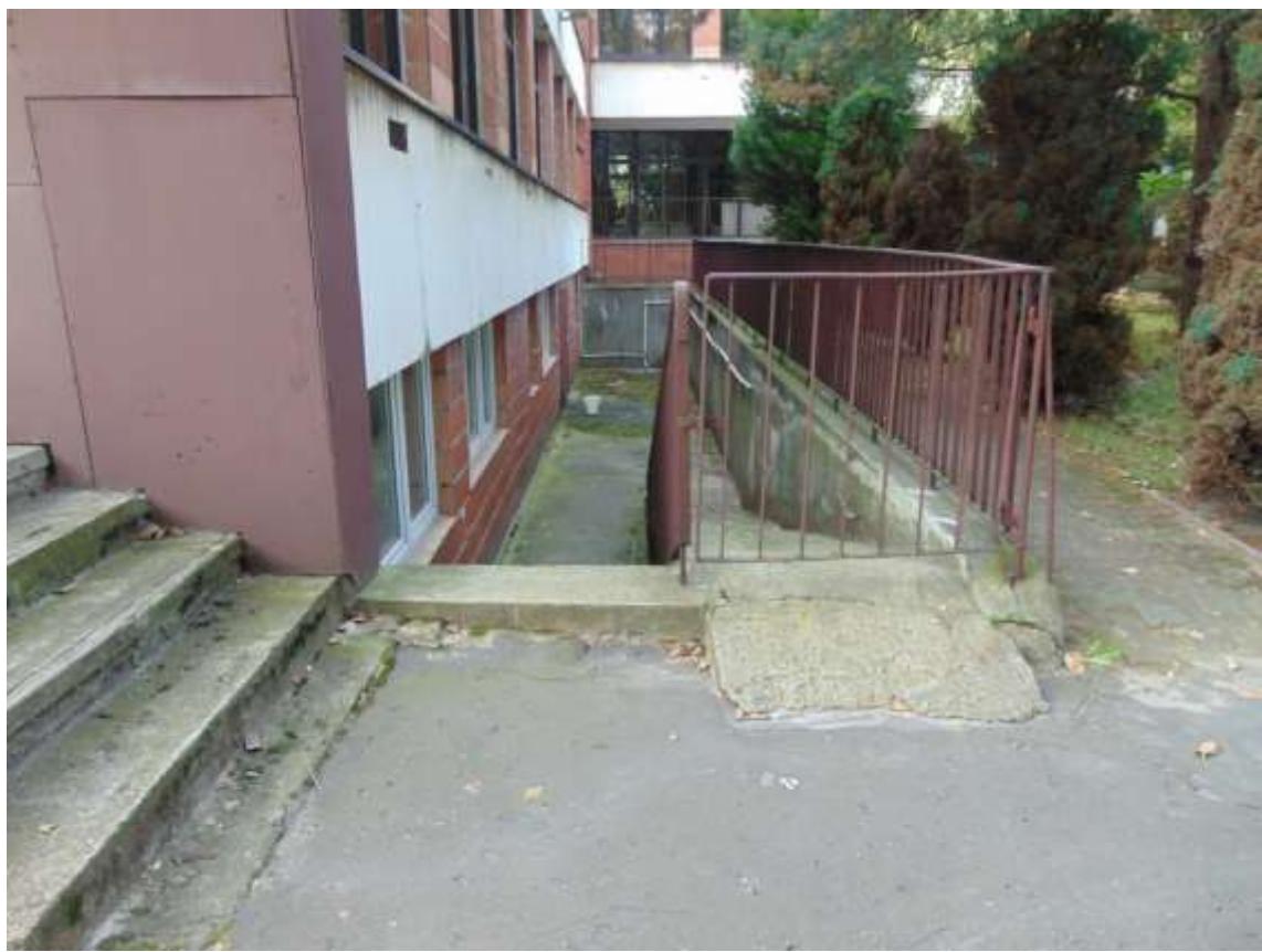
zdjęcie nr 12 - widok elewacji nr 3
