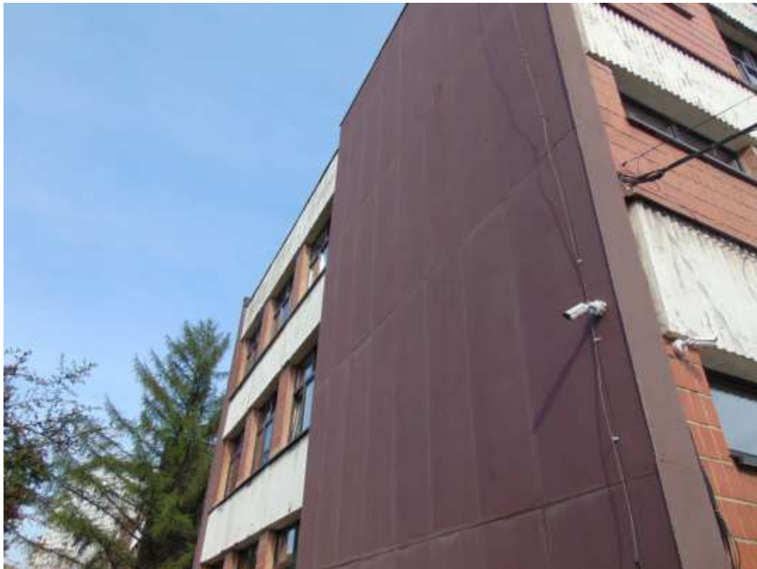
zdjęcie nr 5 - widok elewacji nr 5
