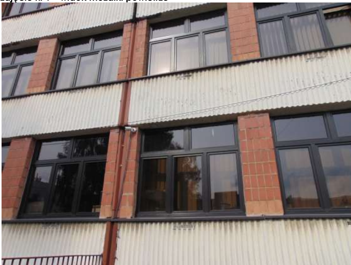
zdjęcie nr 10 - widok elewacji nr 6
