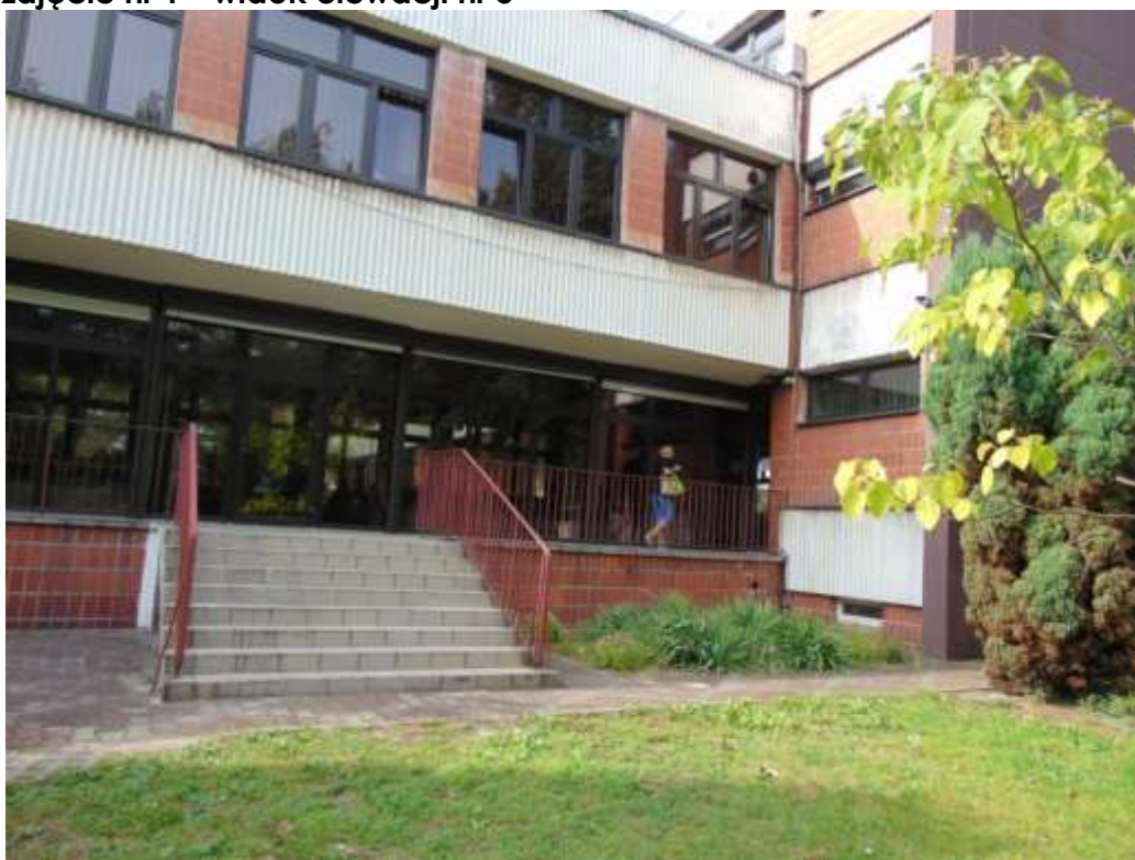
zdjęcie nr 2 - widok elewacji nr 5
