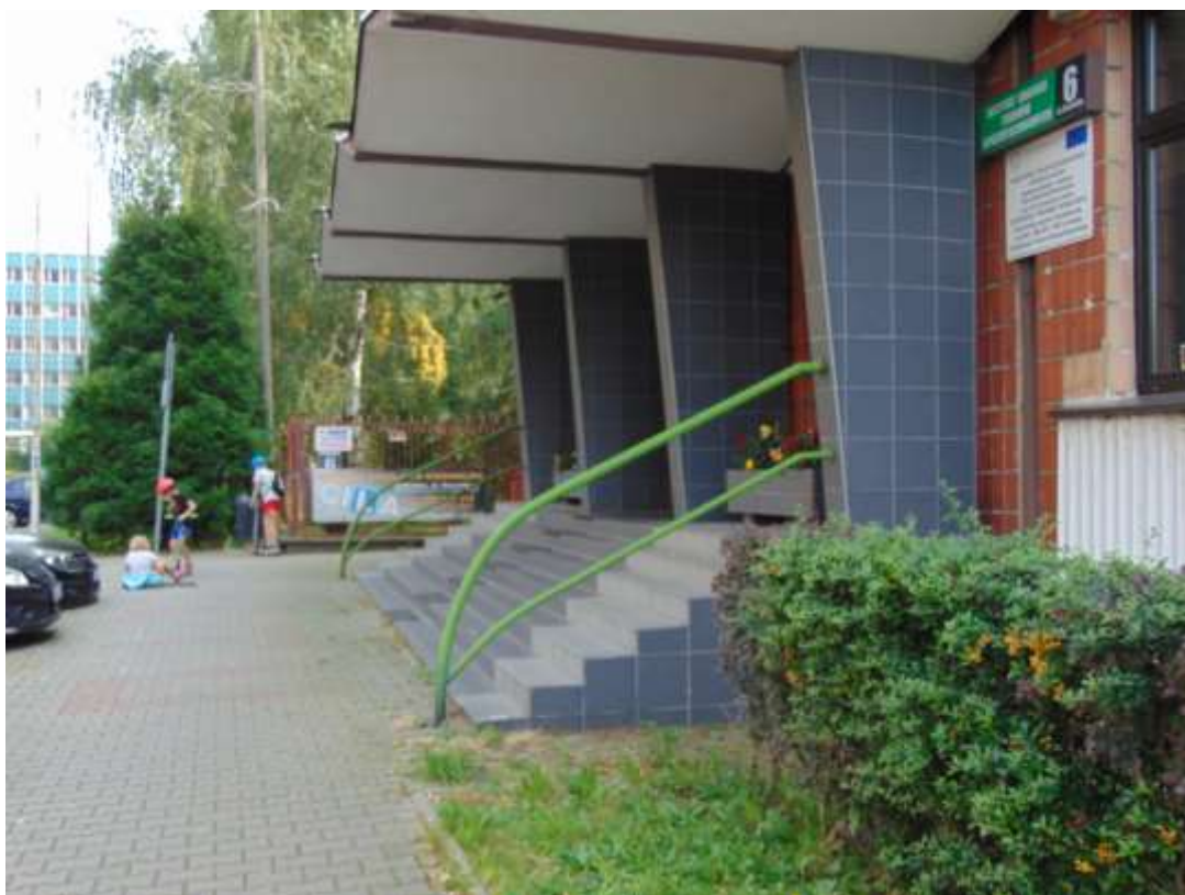
zdjęcie nr 6 - front budynku, elewacja nr 1
