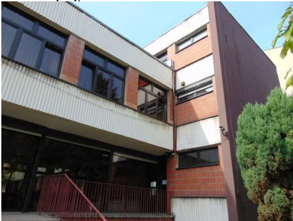
zdjęcie nr 1 - widok elewacji nr 5
