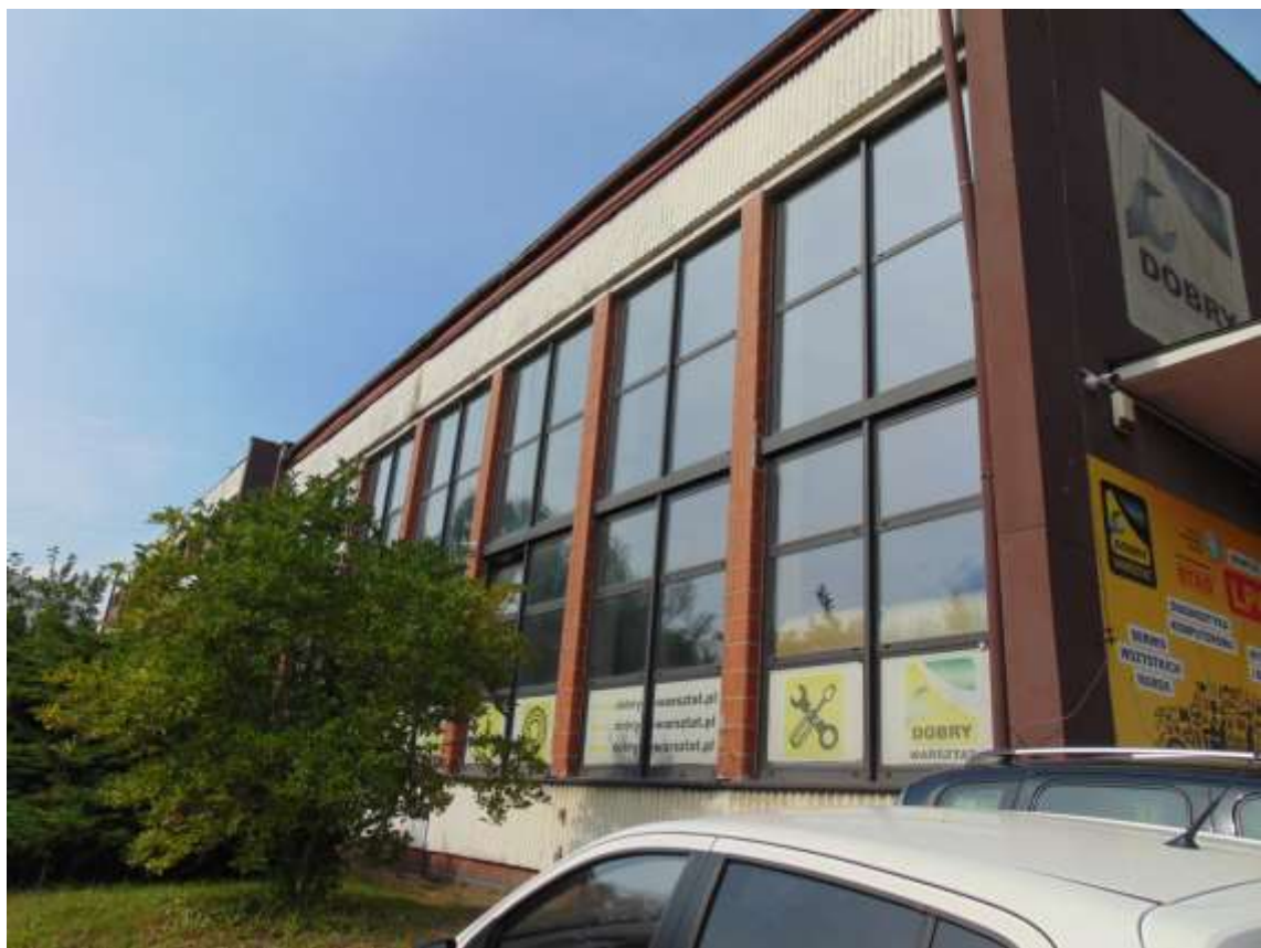
zdjęcie nr 11 - widok elewacji nr 4
