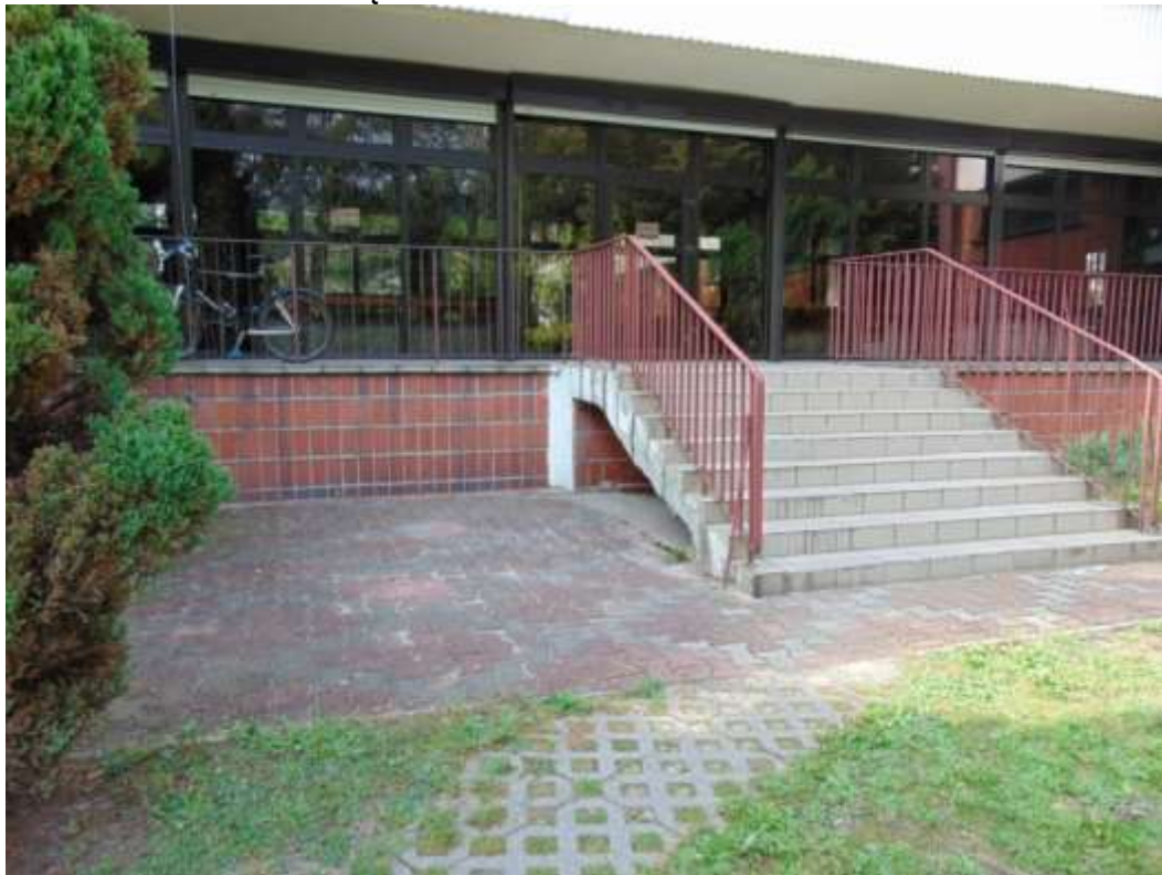
zdjęcie nr 13 - elewacja nr 2
