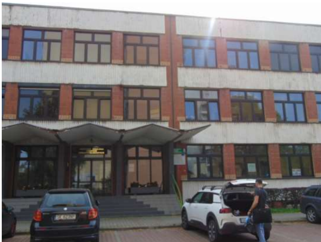
zdjęcie nr 21 - Elewacja frontowa budynku głównego "A"
